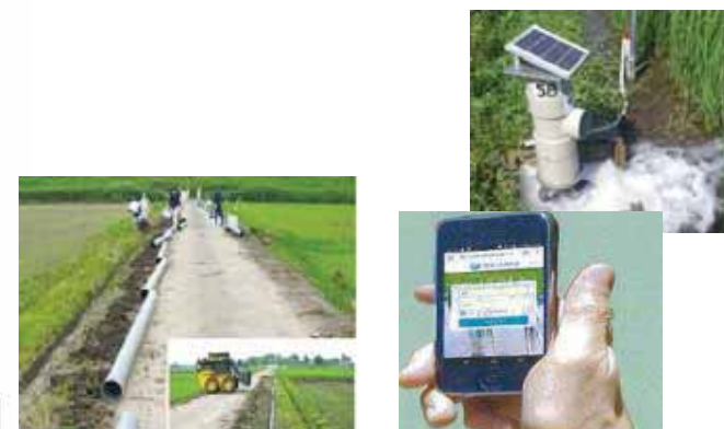
水路の管路化
