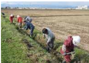
水路の泥上げ
