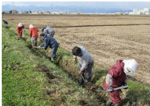
水路の泥上げ
