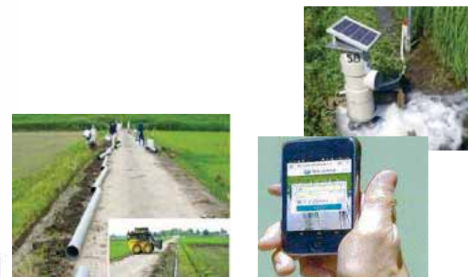
水路の管路化
