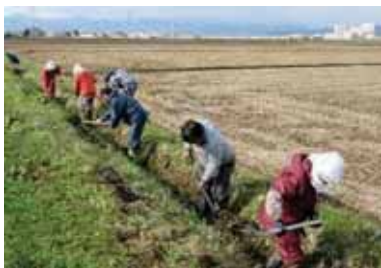
水路の泥上げ
