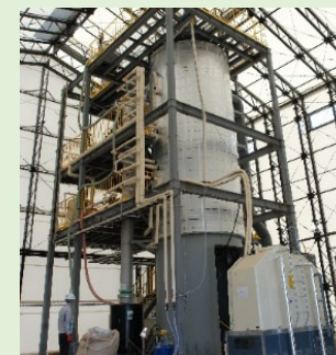
メタン発酵施設
