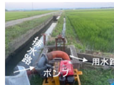
ポンプを用いた用水の確保
