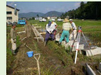
地域住民が参加する直営施工による水路の更新
