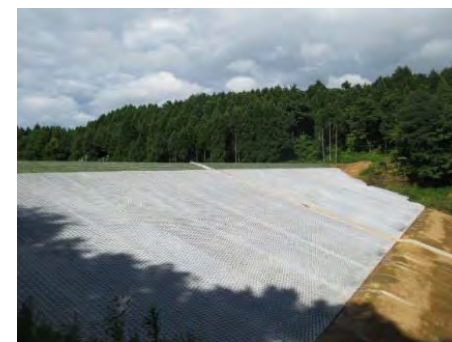
ため池の防災工事により下流の被害を防止(鳥取県)
