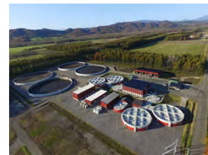
バイオガスプラントの稼働を通じた エネルギーの地産地消の取組(北海道) 資料：北海道鹿追町
