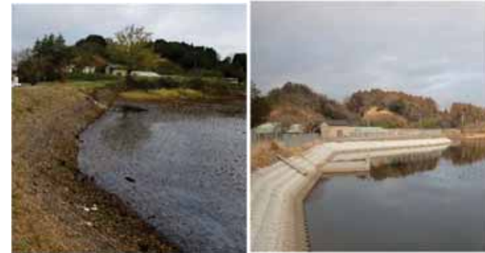
高上げ工事前後のため池堤体
