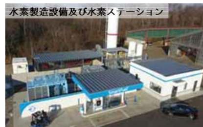
水素製造設備及び水素ステーション
