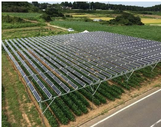
発電施設の外観
