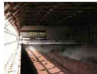
堆肥センター
