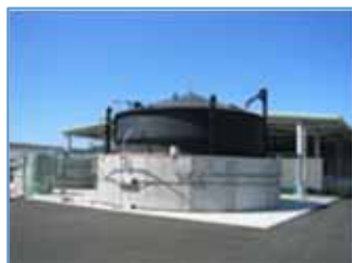
バイオガス発電
