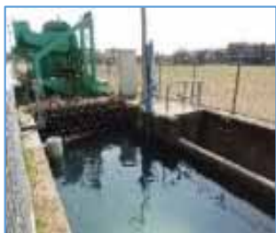
農業水利システムでの 小水力発電
