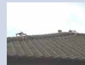
畜舎屋根へのスプリンクラー設置
