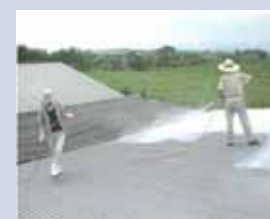
畜舎屋根への石灰塗布
