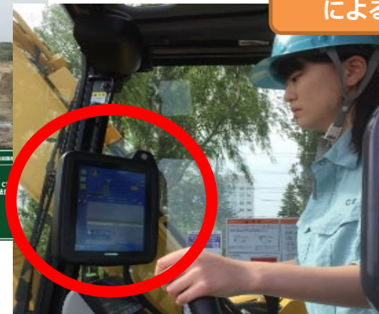
③ ICT建設機械 による施工
