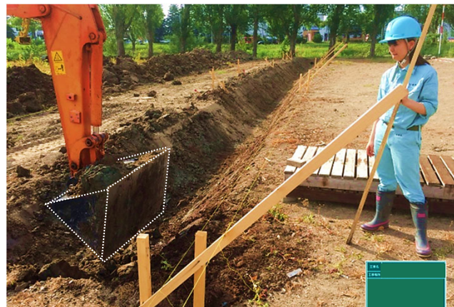
従来施工による法面整形工
