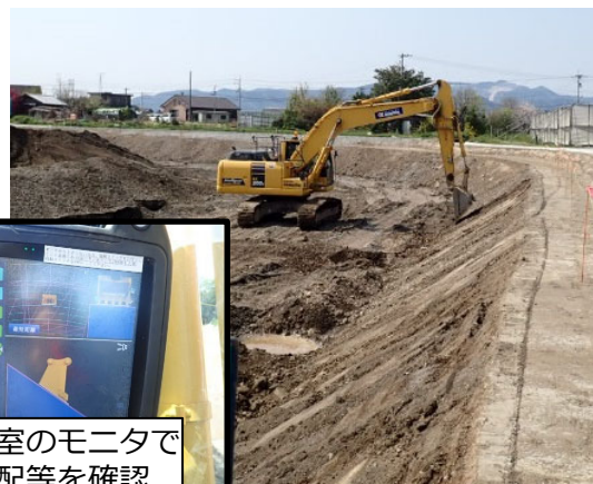
ICT建設機械による法面整形工
