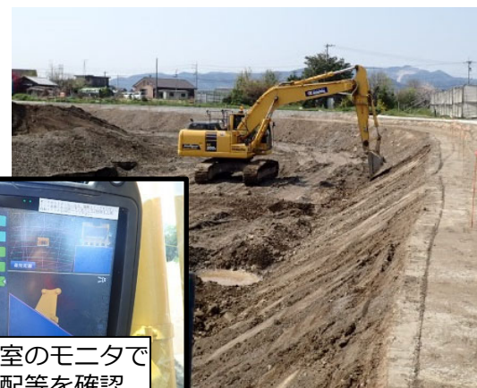
ICT建設機械による法面整形工
