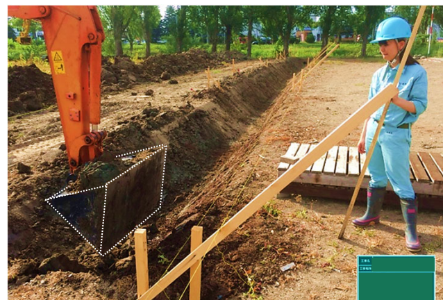
従来施工による法面整形工
