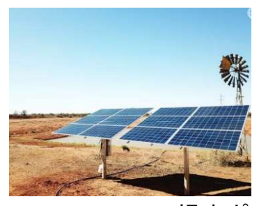
揚水ポンプの動力源となるソーラーシステム
