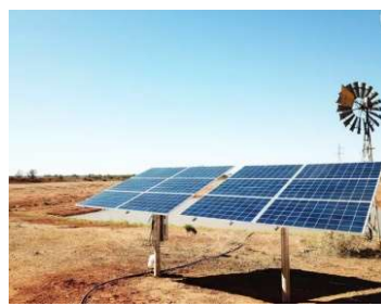
揚水ポンプの動力源となるソーラーシステム
