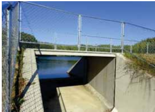
洪水吐きの改修
