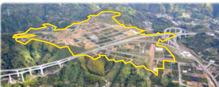
建設発生土を受け入れ、約84億円のコストを縮減するとともに、道路用地を創出した「新丹谷地区」
