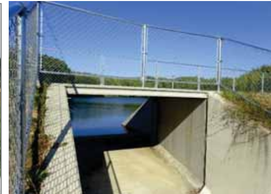
洪水吐きの改修
