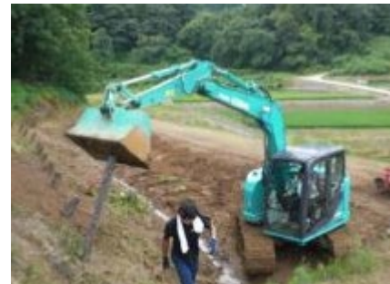
中山間地の地滑り防止工事
