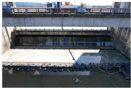
維持管理の取組 （関川頭首工エプロン補修）
