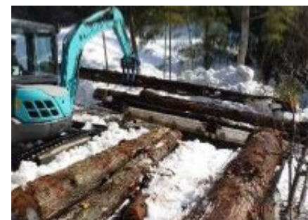
農業用水路の立木伐採
