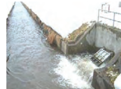
消流雪用水の用水路への注水
