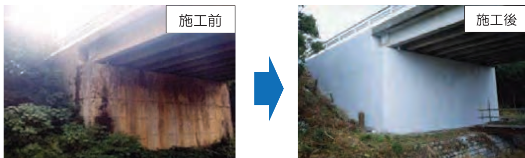
老朽化対策を実施した農道橋
