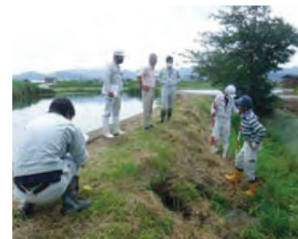
防災重点農業用ため池 の巡回点検
