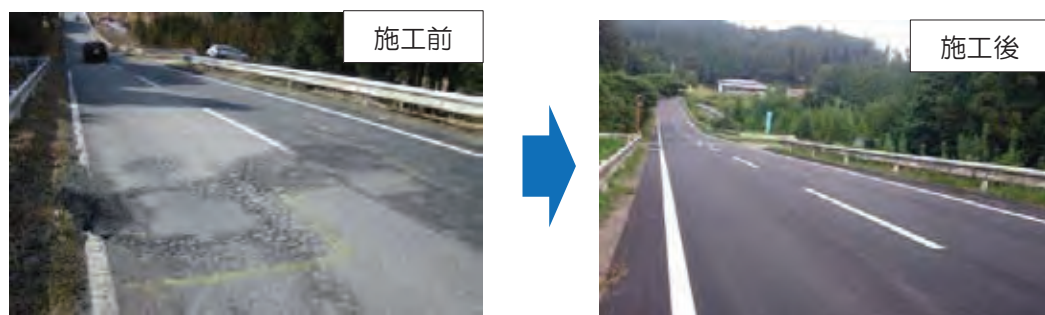
路面改良を実施した農道
