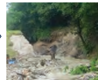
復旧部分が豪雨で再度被災
