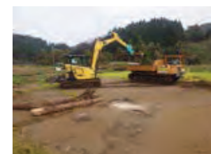
農地への堆積土砂・流木撤去
