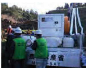
ため池における排水ポンプ設置
