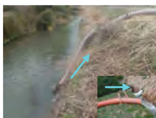
仮設ポンプ設置
