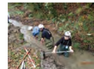
人力による堆積土砂撤去
