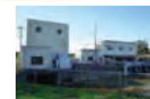
排水機場の監視・制御
