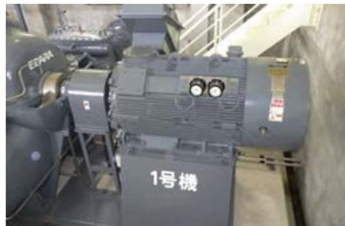
高効率電動機への更新による
