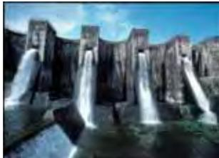
豊稔池堰堤は、現存する日本最古の石積み式マルチプルアーチダムである。大正15年から4年の歳月と延べ15万人の労力を投入して完成し、今日も築造当時の勇壮な姿のままに洪水調節とかんがい用水の貯水機能を果たしている。
