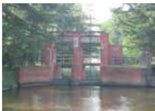
常西合口用水は、常願寺川左岸の洪水対策を目的とし、オランダ人技師ヨハネス・デ・レーケの指揮の下に明治26年に完成した疏水である。周辺の樹木の緑に映えるレンガ造りの排砂水門（写真上）は明治33年に完成し、「新庄の赤門」と呼ばれ、平成5年に補修されているものの、現在も築造当時の姿をとどめており、かつての技術が「用」、「強」、「美」の考えを踏まえていたことを偲（しの）ばせる。
