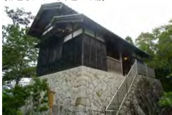
〔保全されている水屋の外観〕
