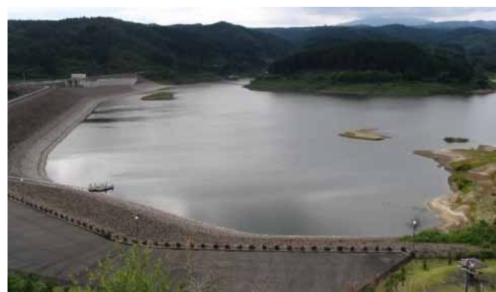
整備後11年経過
