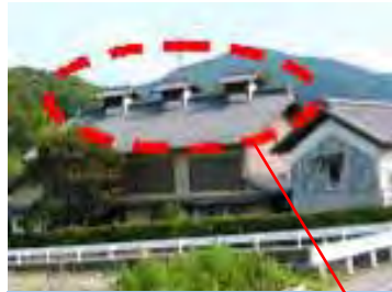
高窓のある切妻屋根
