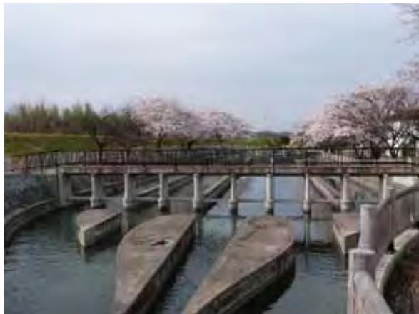
〔沈砂池の改修後の開放区間〕
