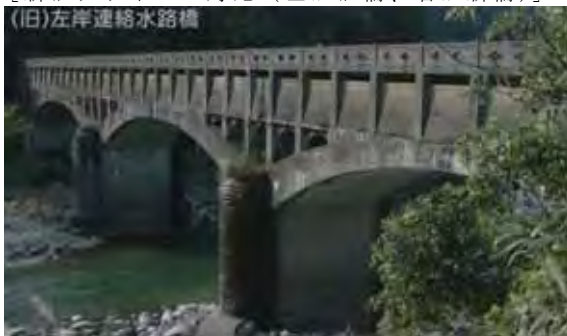
(旧)左岸連絡水路橋
