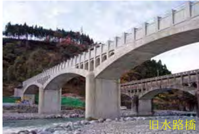
整備中(新橋、旧橋)
