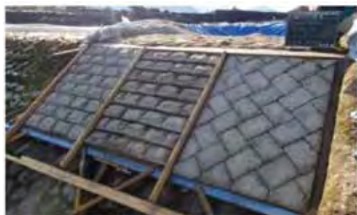
[試験施工状況 (左No.1、中No.2、右No.3)]
