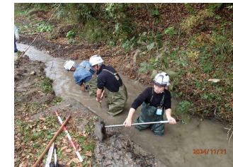
人力による堆積土砂撤去
