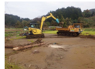
農地への堆積土砂・流木撤去
