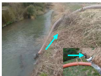
仮設ポンプ設置
