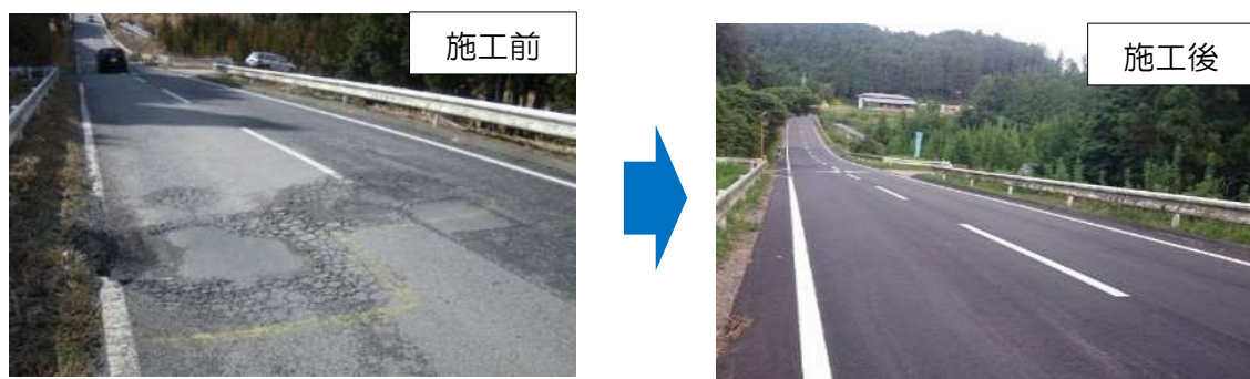
路面改良を実施した農道
