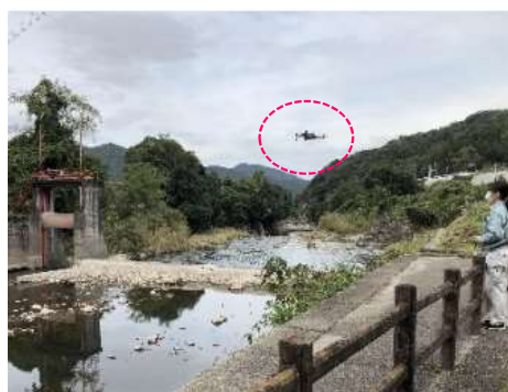
UAV (ドローン) による 頭首工の点検
