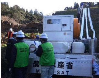
ため池における排水ポンプ設置
