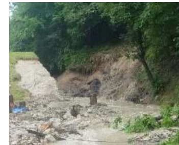
復旧部分が豪雨で再度被災
