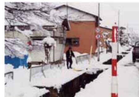
用水路への排雪作業
