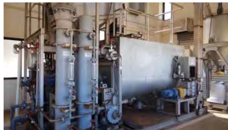
管内の堆肥化施設の事例（徳島県海洋町）
