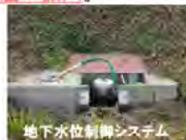
地下水位制御システム
