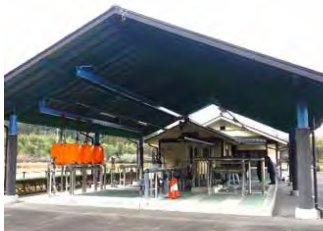
管内の農業集落排水施設の事例（岡山県鏡野町）
