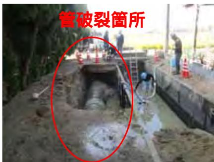
地中に埋設された管が破裂する漏水事故が発生
