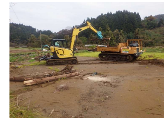
農地への堆積土砂・流木撤去
