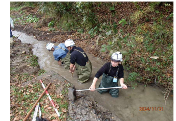
人力による堆積土砂撤去
