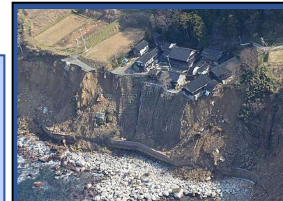
写真⑤ 斜面の崩落、護岸の破損（石川県輪島市）
