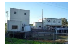
排水機場の監視・制御
