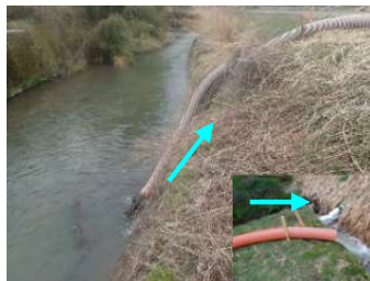
仮設ポンプ設置
