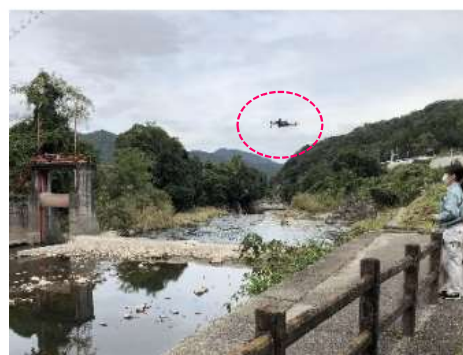
UAV (ドローン) による 頭首工の点検
