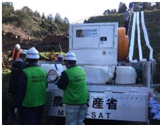
ため池における排水ポンプ設置
