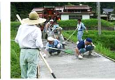
広域体制の下での農道の舗装
