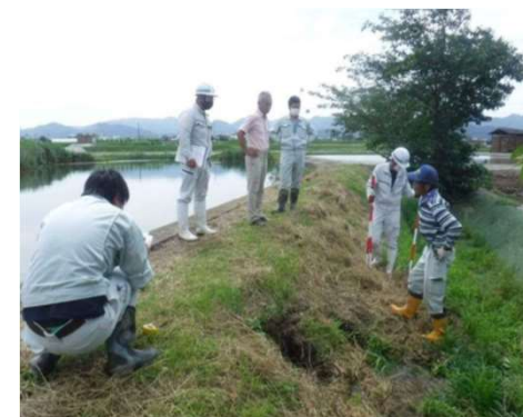
防災重点農業用ため池 の巡回点検
