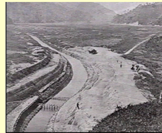
安積疏水(福島県)
