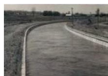
総合かんがい排水事業美瑛地区（北海幹線用水路の改修）
