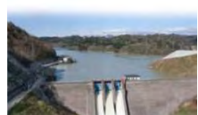
総合かんがい排水事業大夕張地区（大夕張ダム）
