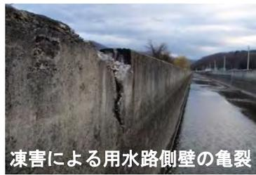
凍害による用水路側壁の亀裂
