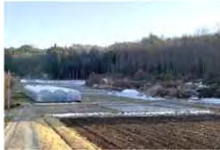
畦畔を除去するとともに、ほ場面に緩傾斜を設け排水性を向上し、水田を畑地化
