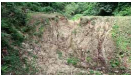
堤体の劣化により、豪雨時に崩落
