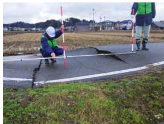
パイプライン埋設道路の被災状況の調査
