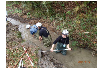
人力による堆積土砂撤去
