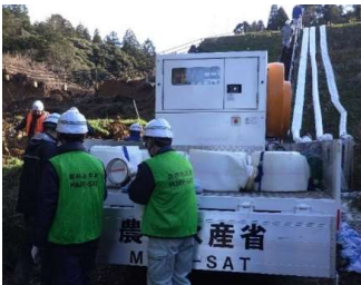
ため池における排水ポンプ設置
