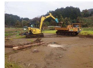
農地への堆積土砂・流木撤去
