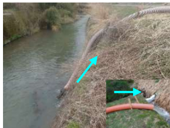
仮設ポンプ設置
