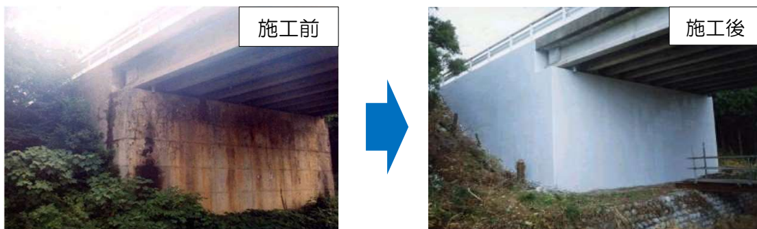
老朽化対策を実施した農道橋
