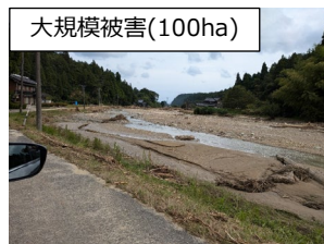
大規模被害(100ha) 河川復旧＋農地復旧 ⇒少なくとも4～5年以上必要
