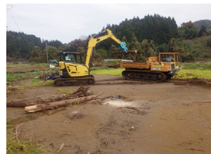
農地への堆積土砂・流木撤去
