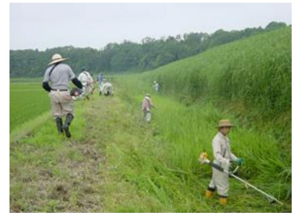
多くの人力が必要となる排水路（開水路）法面の草刈り
