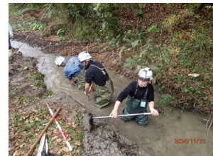
人力による堆積土砂撤去
