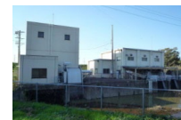
排水機場の監視・制御
