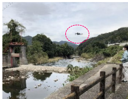
UAV (ドローン) による 頭首工の点検
