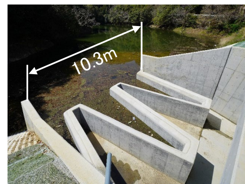
豪雨対策（洪水吐きの改修）の先行整備（例） ※地震対策は豪雨対策完了後に実施
