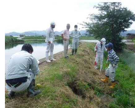
防災重点農業用ため池 の巡回点検
