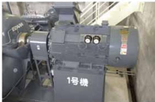
高効率電動機への更新による
