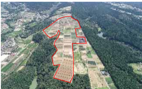
整備後の状況
