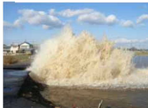
管水路の突発事故（管の破裂）
