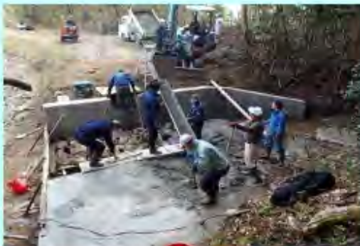
ため池余水吐更新の直営施工
