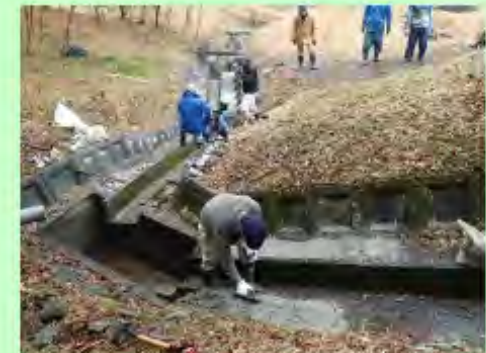
水路補修工事の直営施工
