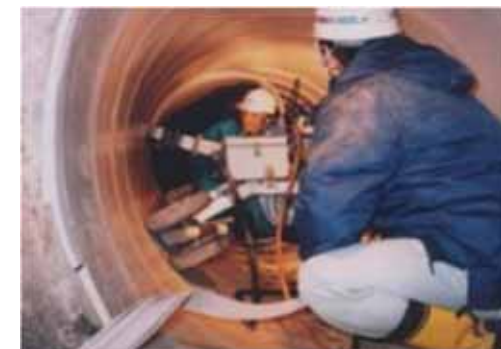
管水路の調査点検・機能診断
