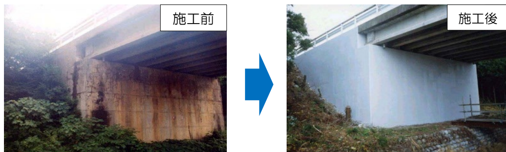
老朽化対策を実施した農道橋
