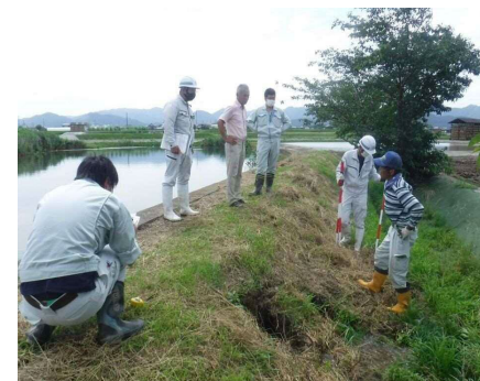
防災重点農業用ため池 の巡回点検
