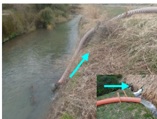
仮設ポンプ設置
