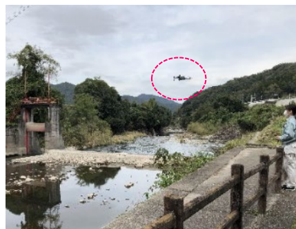
UAV（ドローン）による 頭首工の点検
