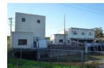
排水機場の監視・制御
