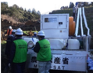
ため池における排水ポンプ設置
