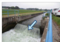
発電地点（設置前）
