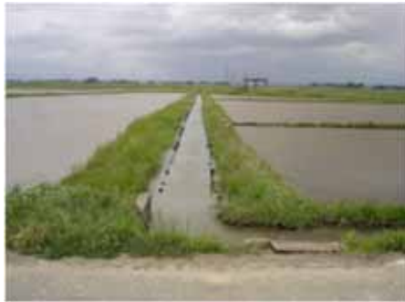
用排水路が未整備で排水不良や湿害が発生
