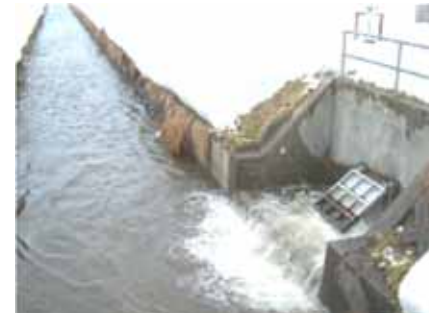
消流雪用水の用水路への注水
