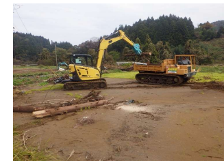
農地への堆積土砂・流木撤去
