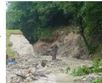
復旧部分が豪雨で再度被災
