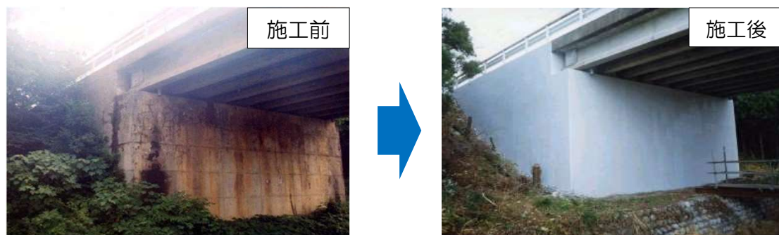
老朽化対策を実施した農道橋
