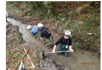
人力による堆積土砂撤去
