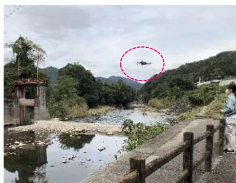
UAV (ドローン) による 頭首工の点検
