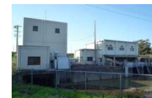
排水機場の監視・制御
