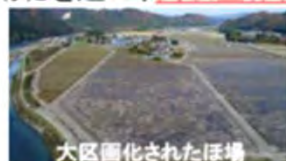
大区画化されたほ場
