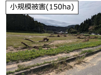
土砂等の除去＋用水等の確保 ⇒営農再開が可能
