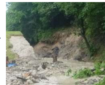
復旧部分が豪雨で再度被災
