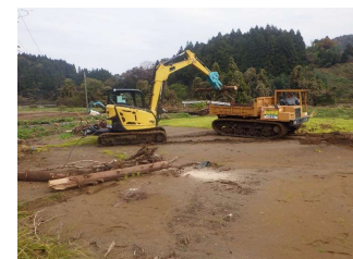
農地への堆積土砂・流木撤去
