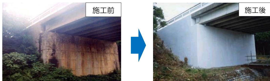
老朽化対策を実施した農道橋
