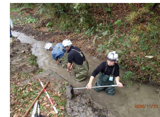
人力による堆積土砂撤去
