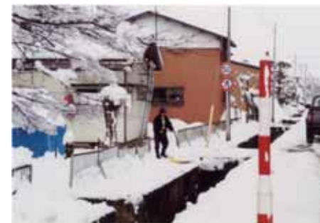
用水路への排雪作業
