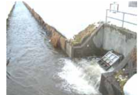
消流雪用水の用水路への注水
